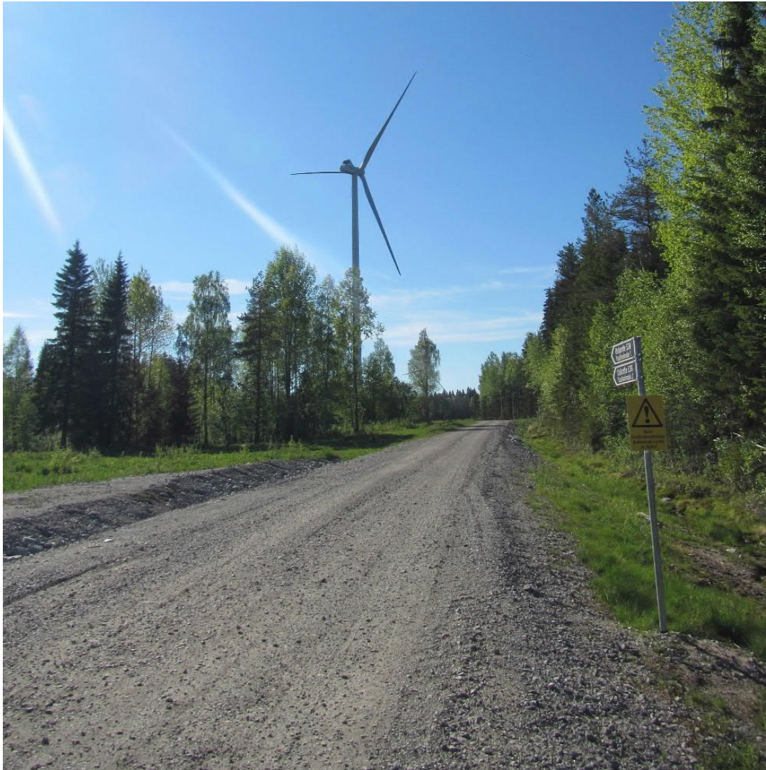
Kuva 3-6. Esimerkki tuulipuiston rakennus- ja huoltotiestä. © AFRY Finland Oy.
