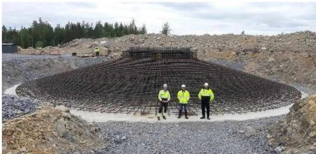
Kuva 3-8. Tuulivoimalan perustustyömaa. © Ilmatar Energy Oy.
